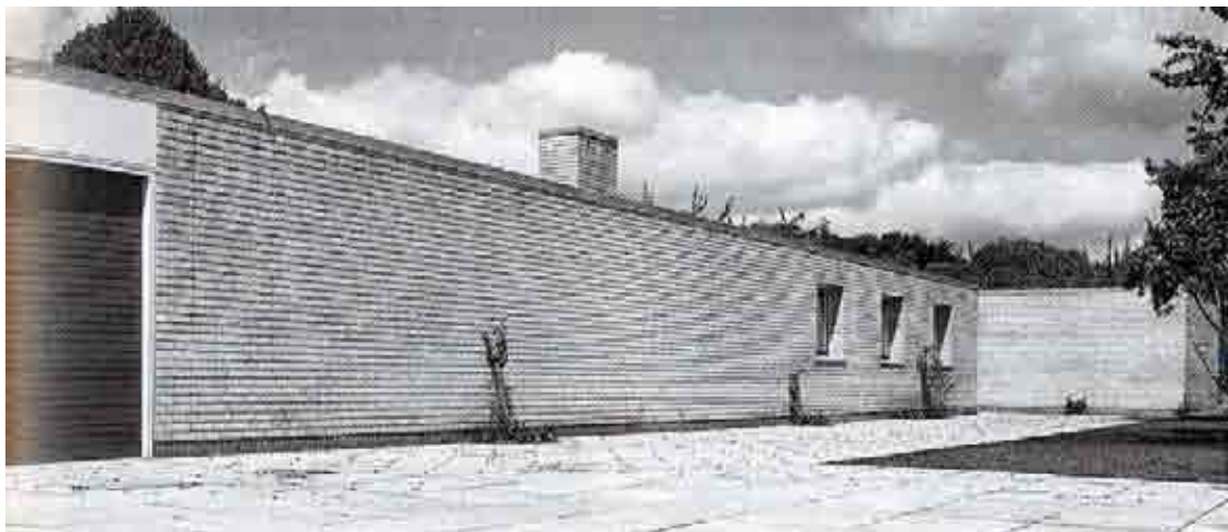
A. Jacobsen, 1.961. Foto del muro casi ciego de la fachada lateral
