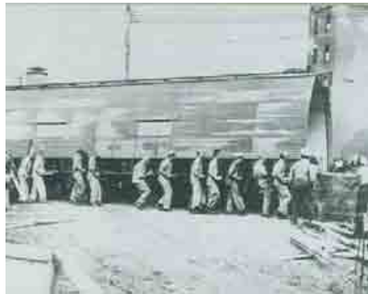
Quonset hut movido por trailer e instalado, 1948
