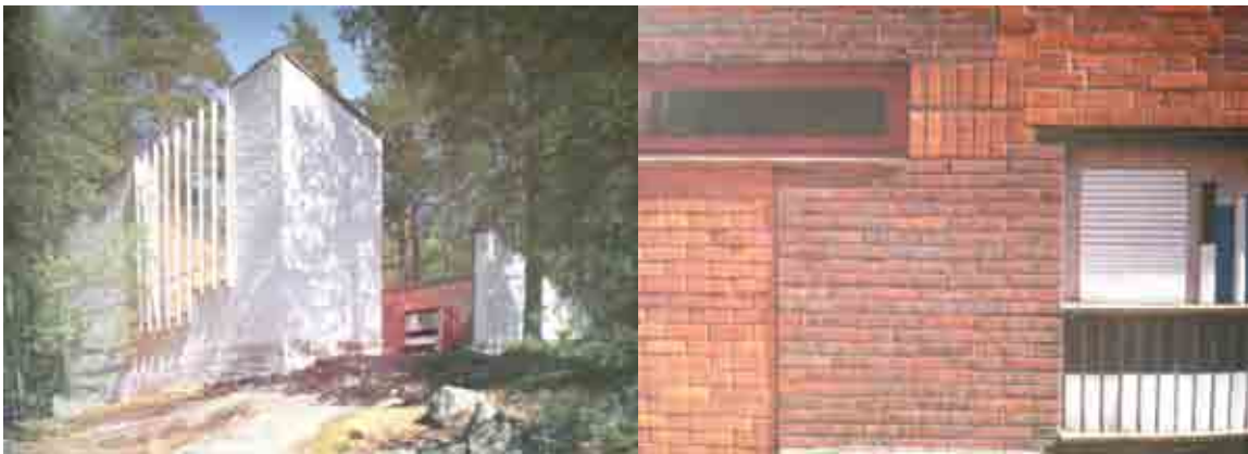
Foto del muro desde el exterior del patio. Detalle del cerramiento de la casa al interior del patio.
