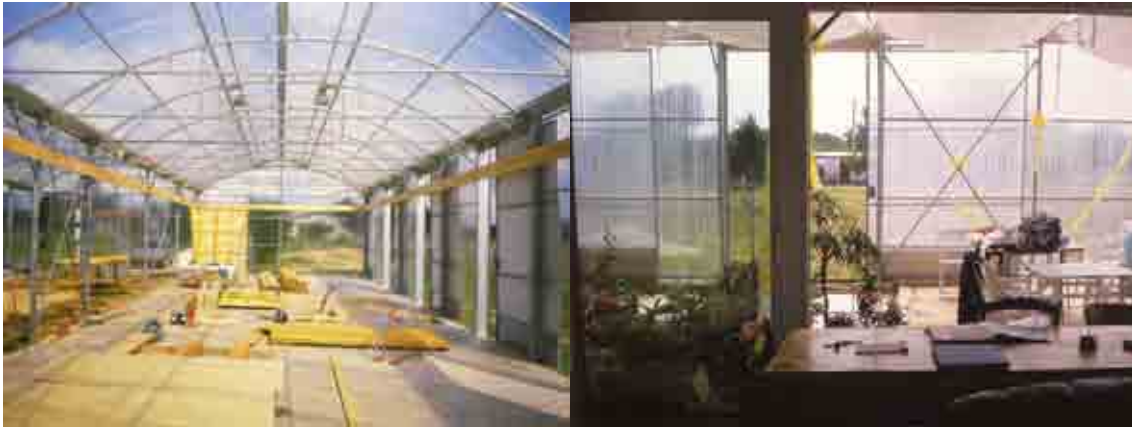
Fotos interiores de la casa en Coutras, Gironde, Francia. Proceso constructivo y estado en uso
