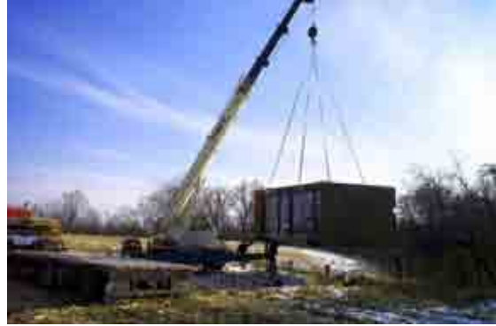
Montaje y colocación de la Weehouse
