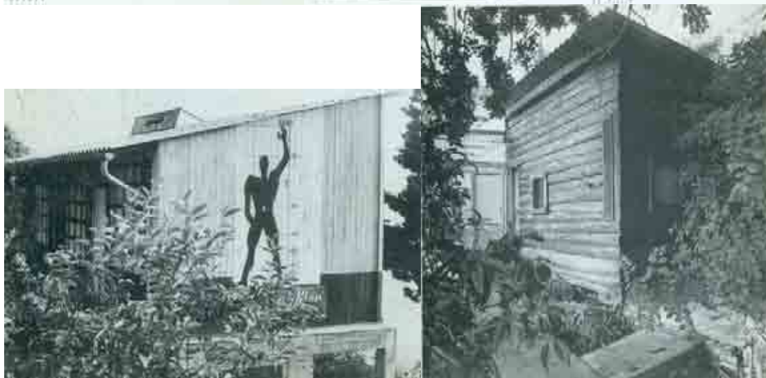
Planta, alzados interiores y exterior. Fotos. Le Cabanon, Cap Martin, Roquebrune, Francia. Le Corbusier, 1.952
