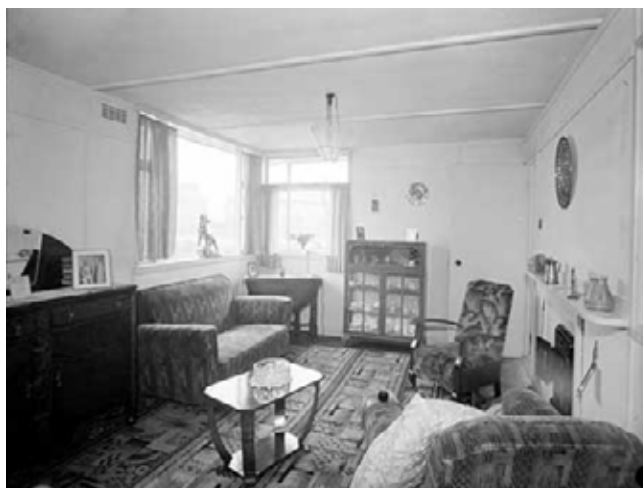
Interior de una de las viviendas. Salón
