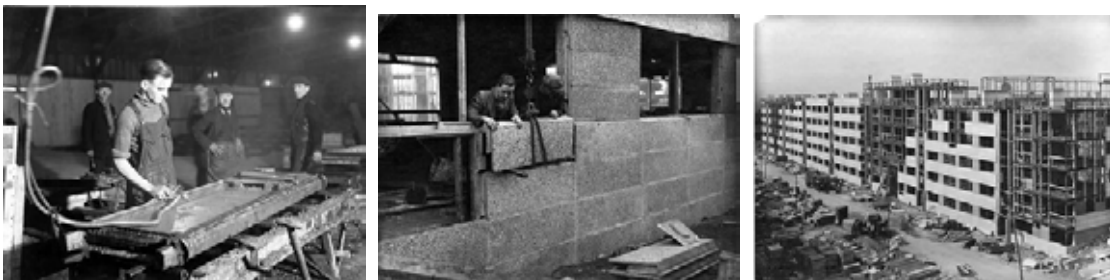
“Quarry Hill Flats” Fabricación de los paneles de hormigón / Colocación / Edificio en Construcción.
