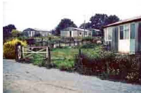
Vivienda prefabricada Arcon en GLC en Debden, Essex.
